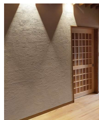
珪藻土塗りに間接照明
