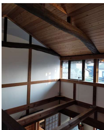
吹抜けの漆喰壁
